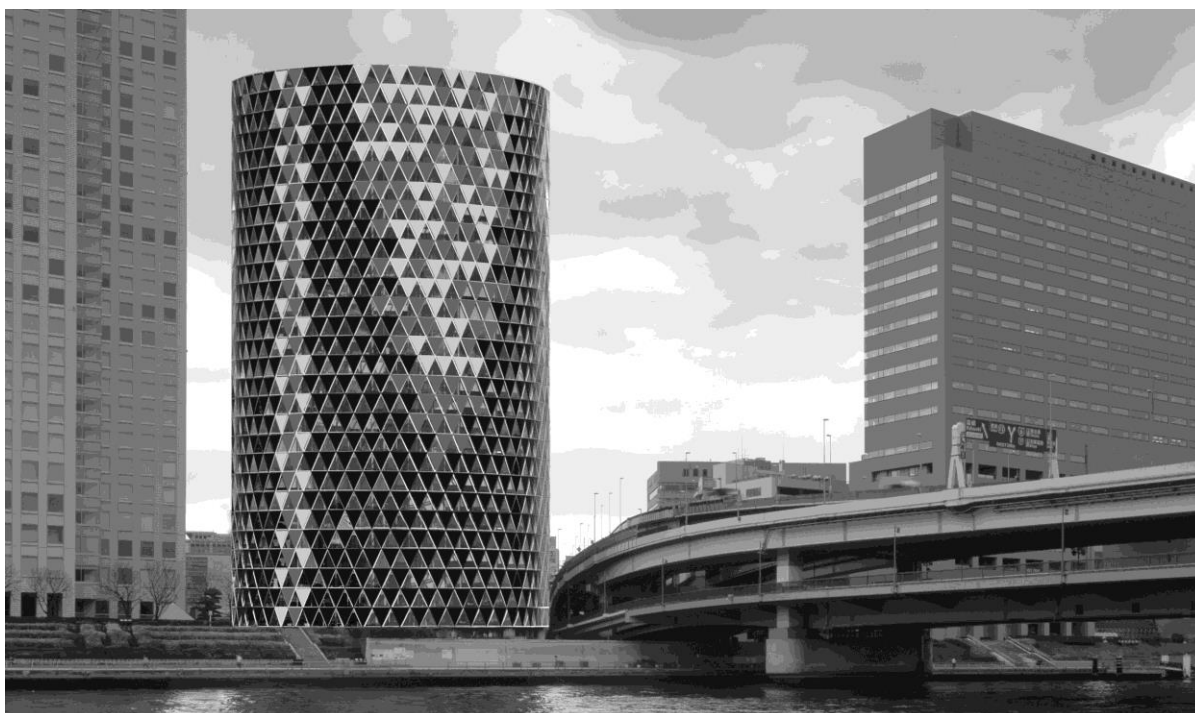
44. Wizualizacja systemu zaciemniania elewacji przez modułarny system oparty o jednowymiarowy trzykolorowy trójkątny automat komórkowy 1D3Cr-1/2 kod 226.
