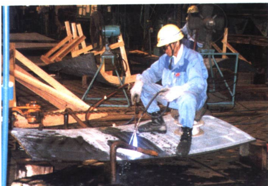
Rys. 31. Ręczne kształtowanie termiczne blach.
