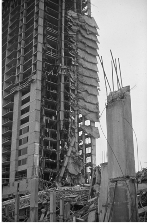
Rysunek 2.2: Budynek Skyline Plaza w Crossroads Bailey po katastrofie budowlanej w 1973 roku - źródło [139]
