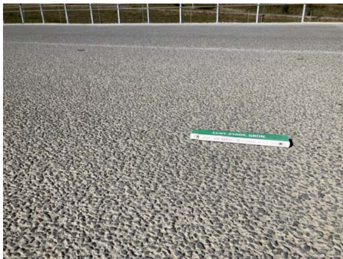
Fot. 1. Widok nawierzchni betonowej wykonanej metodą ślizgową z teksturą odkrytego kruszywa na odcinku drogi klasy S i kategorii ruchu KR7 (fot. własna autora)
