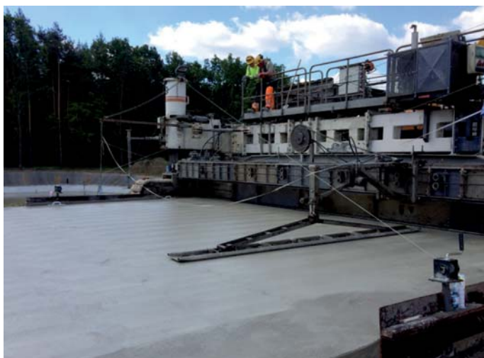
Fot. 2. Widok nawierzchni po przejściu układarki (widoczne stalowe boki formy ślizgowej, stół dociskowy oraz listwa wyrównująca)
