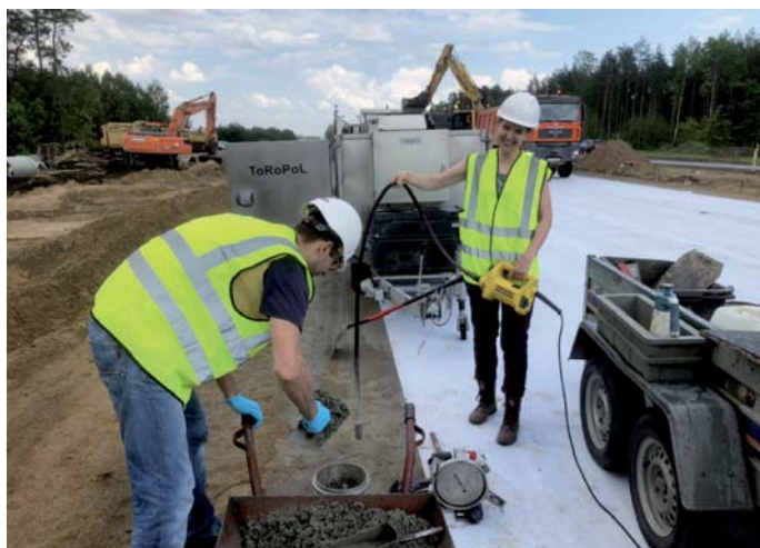
Fot. 5. Widok urządzenia Super Air Meter w użyciu na placu budowy drogi ekspresowej [18]
