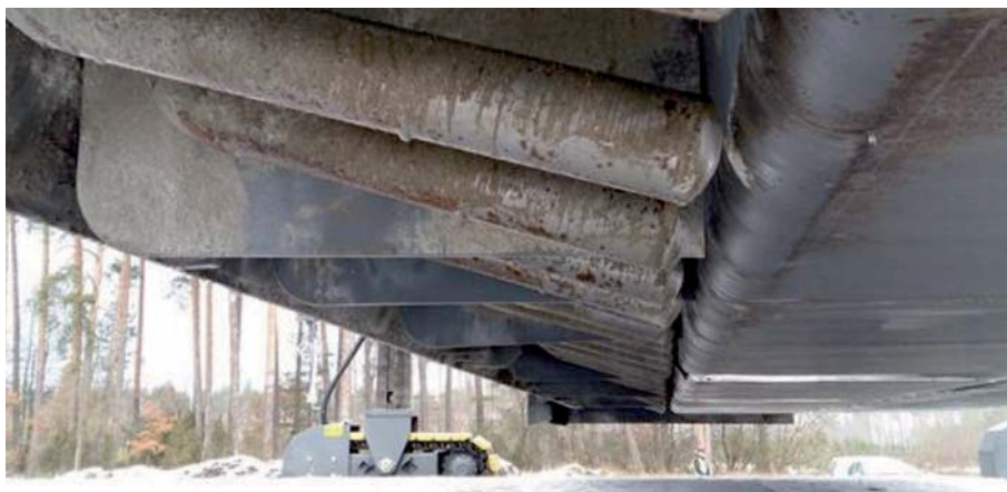
Fot. 3. Widok czoła układarki z boku od spodu: zestaw wibratorów i czoło stołu dociskowego, na dole warstwa geowłókniny na podbudowie (fot. własna autora)
