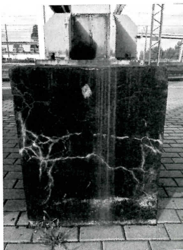
Rys. 2. Betonowe masywne płyty fundamentowe (pod wiaduktem na stacji kolejowej Warszawa Praga) ze spękaniami i wysiękami m.in. z powodu reakcji alkalia-kruszywo.
