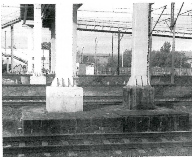
Rys. 2. Betonowe masywne płyty fundamentowe (pod wiaduktem na stacji kolejowej Warszawa Praga) ze spękaniami i wysiękami m.in. z powodu reakcji alkalia-kruszywo.
