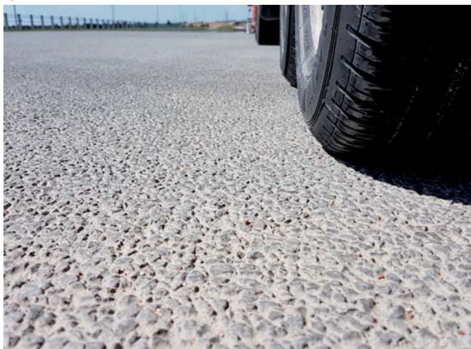
Fot. 1. Ilustracje poszczególnych faz procesów technologicznych pokrywania nawierzchni preparatem opóźniająco-pielęgnującym i szczotkowania oraz widok tekstury gotowej nawierzchni (fotografie autora)
