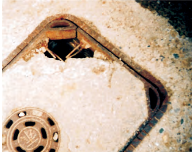
Fot. 1. Zniszczona pokrywa i fragment zwieńczenia – widoczne znaczne ubytki betonu, odkryte zbrojenie, pęknięta oprawa żeliwna pokrywy
