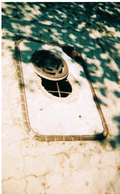
Fot. 11. Pokrywa żelbetowa o wym. 997 × 597 × 80 mm – widoczny wietrznik obok otworu
