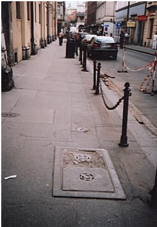
Rys. 1 Typowe uszkodzenia zwieńczeń studni kanalizacji kablowej, zabudowanych w drogach dla pieszych i pojazdów, zaobserwowane w Krakowie i w Warszawie [1]
