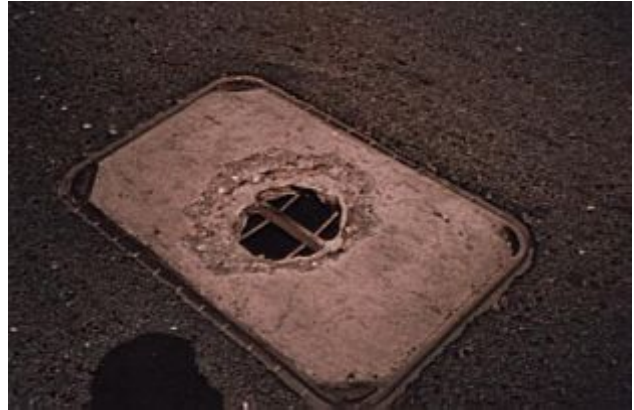
Rys. 1 Typowe uszkodzenia zwieńczeń studni kanalizacji kablowej, zabudowanych w drogach dla pieszych i pojazdów, zaobserwowane w Krakowie i w Warszawie [1]
